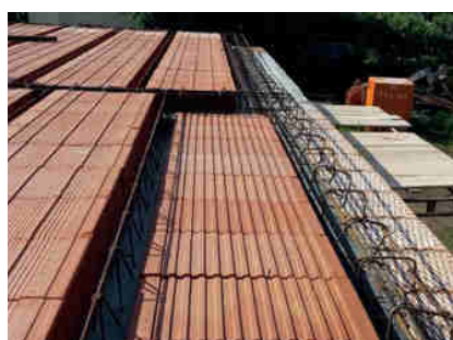
Provedení ztužujících věnců.
