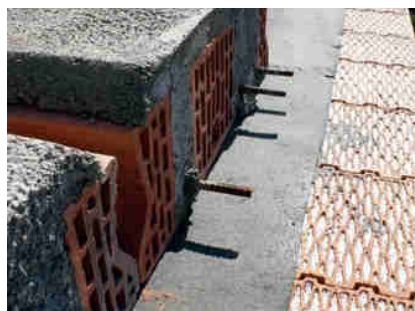
Uložení stropů na asfaltový pás.
