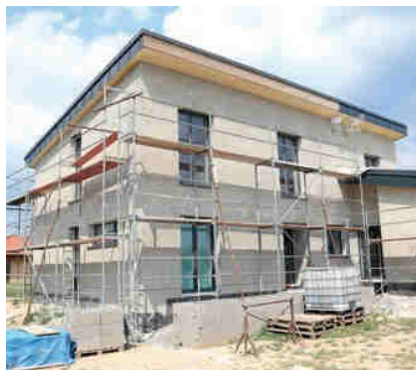
⑤ Provedení jádrové omítky (lehčené nebo tepelněizolační).
