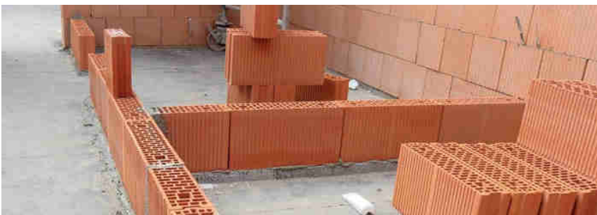
Zdění nenosných stěn (příček).
