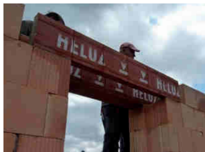
Uložení překladů (překlady HELUZ 23,8) do maltového lože.
