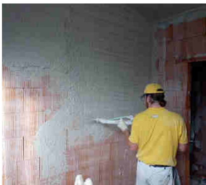
① Strojní nanášení vnitřní omítky.
