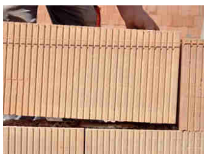
Broušené cihly výšky 249 mm, optimální převazba je ½ délky cihly a minimální 100 mm.
