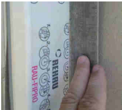
9 Přilepení okenních omítatelných pásek.
