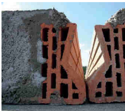
① Detail styčné spáry.
