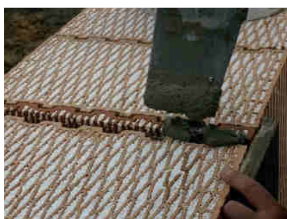
Mezeru mezi cihlami, je nutné vyplnit maltou nebo dořezem cihly a promaltováním (v případě zdění na PU pěnu propěněním dvěma pruhy).
