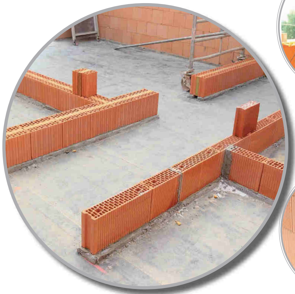
Nosné pilíře se zhotovují v délkovém modulu 250 mm
