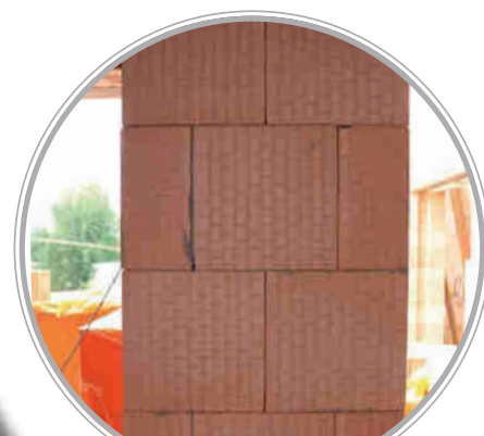
Nosné pilíře se zhotovují v délkovém modulu 250 mm
