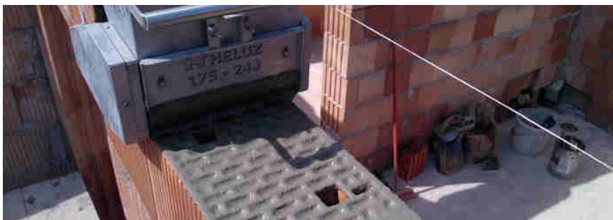
Zdění vnitřních nosných stěn.
