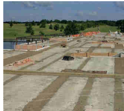
③ K betonáži styčných spár mezi panely se použije beton s maximální velikostí zrna 4 mm pevnostní třídy min. C16/20 - XC1 měkké konzistence S3 dle ČSN EN 206+A1.
