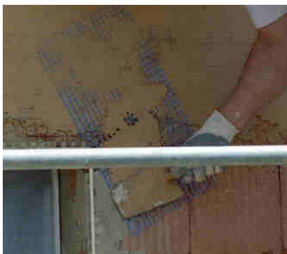
⑦ V místě rohů stavebních otvorů se omítka vyztuží sklotextilní síťovinou (oko min. 8x8mm), aby se předešlo možnému vzniku trhlin omítky v rohu.
