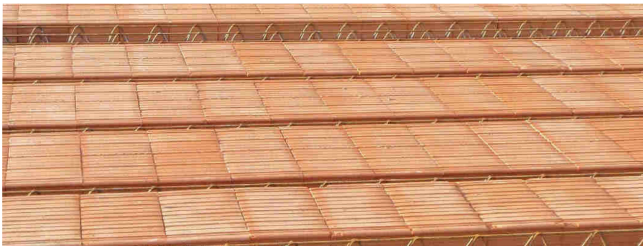
Pohled na uložené nosníky a vložky (před uložením KARI sítě)
