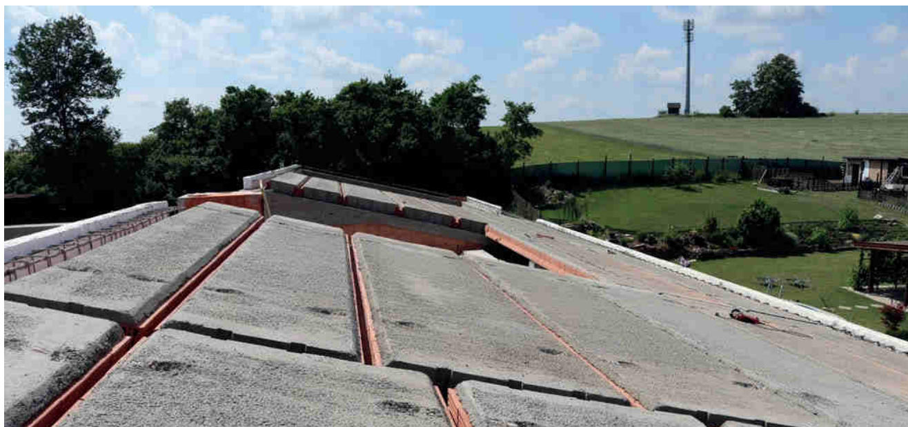
③ K betonáži styčných spár mezi panely se použije beton s maximální velikostí zrna 4 mm pevnostní třídy min. C16/20 - XC1 měkké konzistence S3 dle ČSN EN 206+A1.
